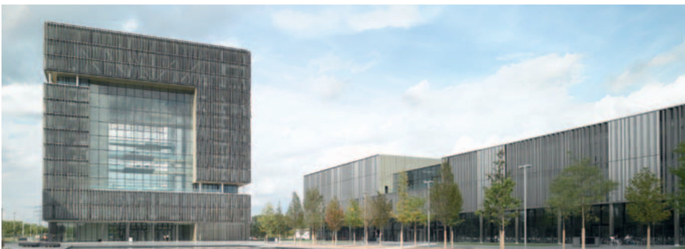
ThyssenKrupp Quartier in Essen mit Hörmann Produkten, DGNB Gold zertifiziert
